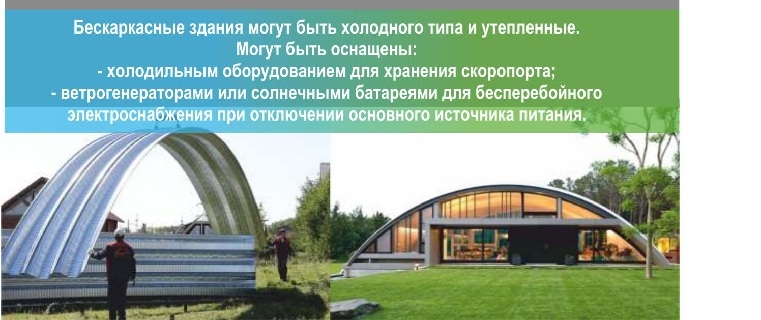
**Бескаркасные здания могут быть холодного типа и утепленные.**
